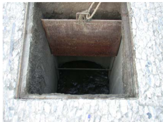
Punto 5 del esquema de la figura 18 Arqueta con vertedero (Sergio Martos Rosillo)
