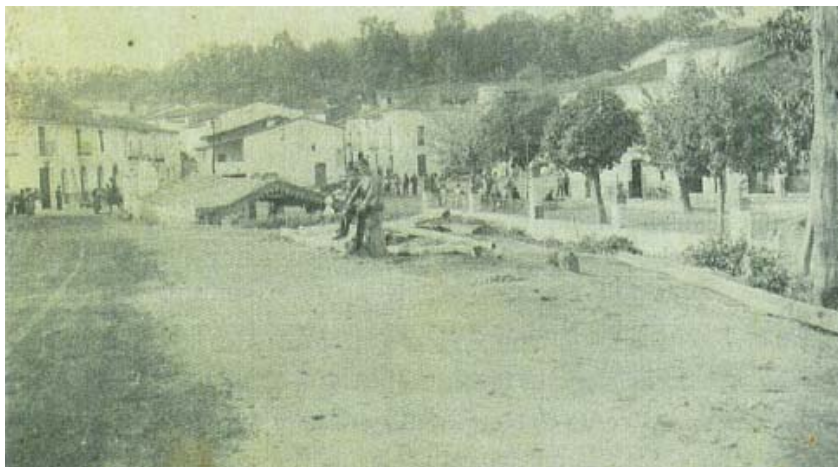
Plaza y Paseo a Galaroza, todavía sin asfaltar, año 1930. La Fuente de los Doce Caños ya está construida y delante se ve el lavadero cubierto (Archivo particular de E. del Valle) (en Macías et al. , 2003)
